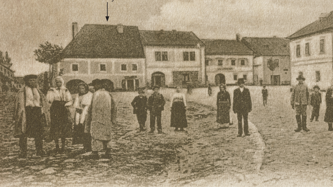
Budova niekdajšieho súdu
