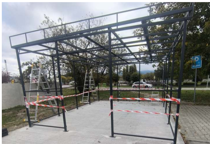
Budovanie stojiska na komunálny odpad na Hollého ul.
